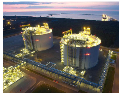
Terminal LNG Świnoujście
